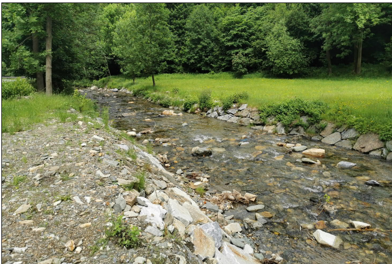
Horní úsek, výrazně lepší úkrytová kapacita vložním balvanů do toku (10. 6. 2022)
