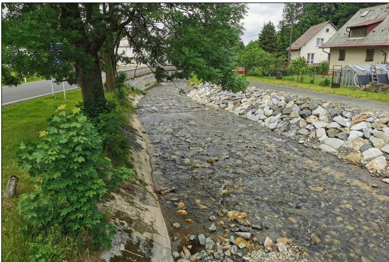
Upravený úsek Bělé, ploché dno bez úkrytů, případné volné kameny a objekty výrazně zvyšují diverzitu toku, 10. 6. 2022 (RK)
